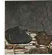
Ημιλαξευτή & αργολιθική πέτρα με μεταγενέστερη επικάλυψη
