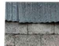
Μεταγενέστερη επέκταση οροφής με χαλυβδόφυλλο και τσιμεντοπλόκ
